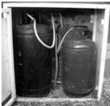
Freistehende Gasanlagen, wie Gasherde oder Grillgeräte können mittels eines speziellen, flexiblen Kunststoffschlauches angeschlossen werden. Der Kunststoffschlauch darf weder belastet, noch so verlegt werden, dass er sich verformt, reißt oder überhitzt wird. Er muss in Italien zugelassen (homologiert) sein, darf eine Gesamtlänge von 1,5 Meter nicht überschreiten und muss mindestens alle fünf Jahre ausgetauscht werden, d.h. innerhalb des Fälligkeitsdatums, das auf dem Schlauch aufgedruckt ist.
